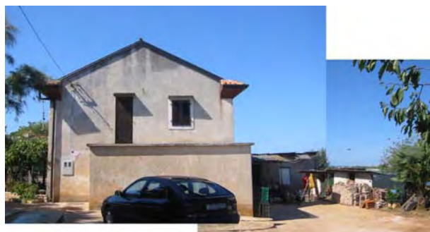
DOGRADNJA POMOĆNIH ZGRADA
