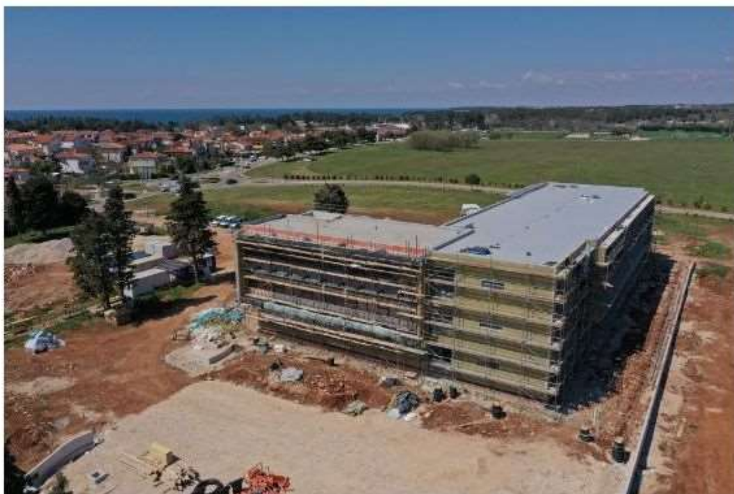
Slika 20 – izgradnja srednje škole Umag (izvor fotografije: mrežne stranice Grada Umaga – Umago - https://umag.hr/ )
