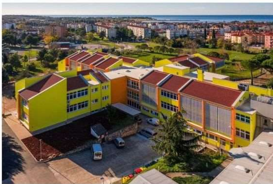
Slika 21 – energetska obnova zgrade osnovne škole Marije i Line (izvor fotografije: mrežne stranice Grada Umaga – Umago - https://umag.hr/ )
