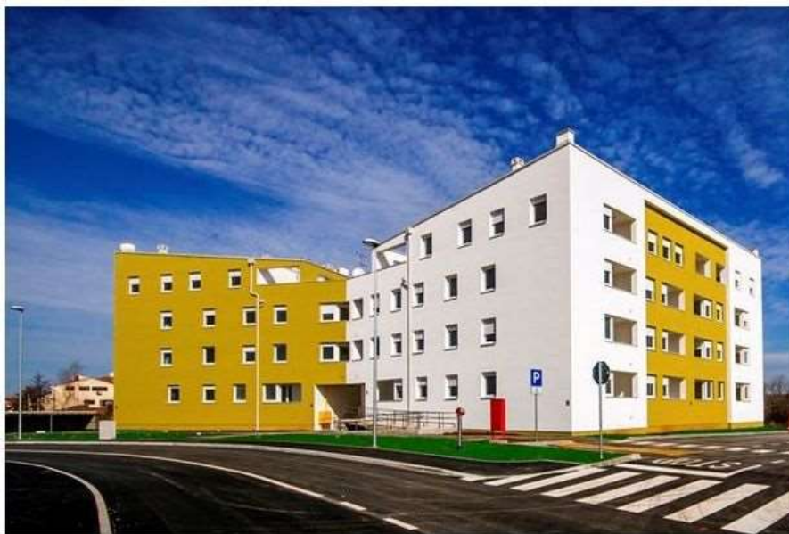
Slika 23 – treća zgrada poticane stanogradnje – lokacija Špinel (izvor fotografije: mrežne stranice Grada Umaga – Umago - https://umag.hr/ )
