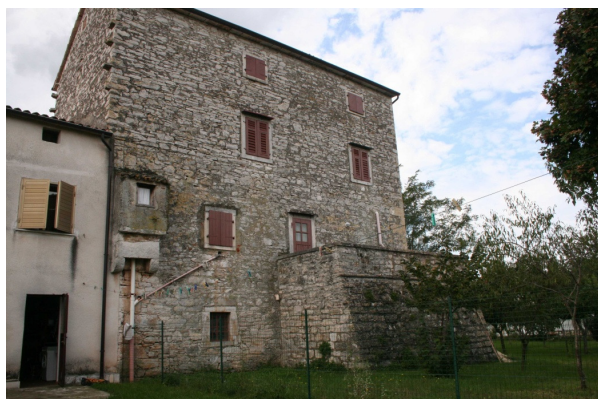
cisterna i WC
