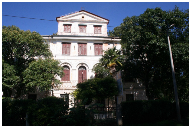
Gospodarska zgrada, pročelje
