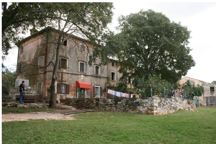
Reprezentativna stambena zgrada s cisternom sa strane
