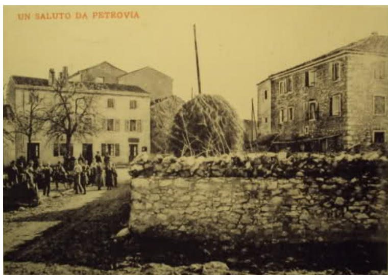
Bunarsko grlo nad cisternom
