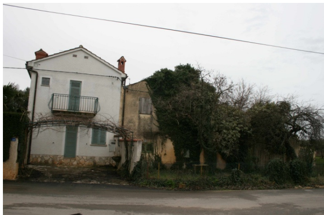
Gospodarske zgrade danas
