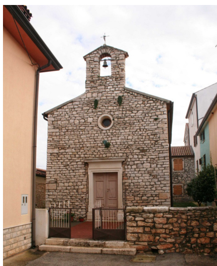
Crkva prije žbukanja vanjskih zidova
