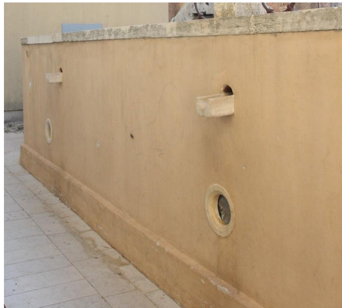
Oluci za prikupljanje kišnice za gradsku cisternu sa sjevernih pročelja kuća koje su bile odvojene ulicom s južne strane (lijevo) i današnji izgled istočnog pročelja, nakon zahvata 2004./2005. godine fotografija lijevo preuzeta iz: Pozdrav iz Umaga, str. 68.; fotografija desno: L. Jonjić, 2011.
