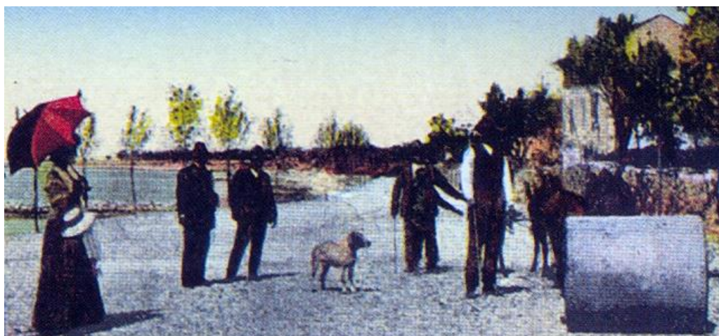
Nasuta obala se je učvršćivala valjkom koji je vukla mula preuzeto iz: Pozdrav iz Umaga, str. 104.
