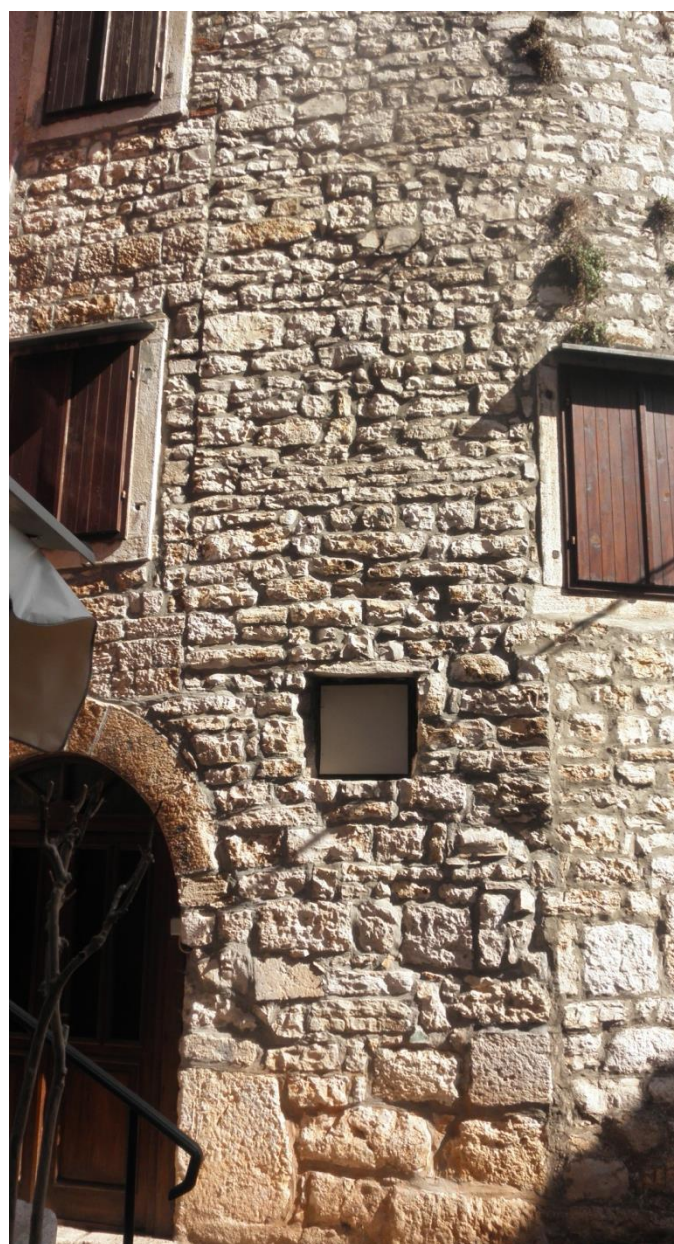
Vertikalne fuge na zapadnom pročelju kuće u današnjoj Riječkoj ulici (lijevo) i na zapadnom pročelju kuće u današnjoj Ulici sv. Mihaela ( desno) fotografije: L. Jonjić, 2011.
