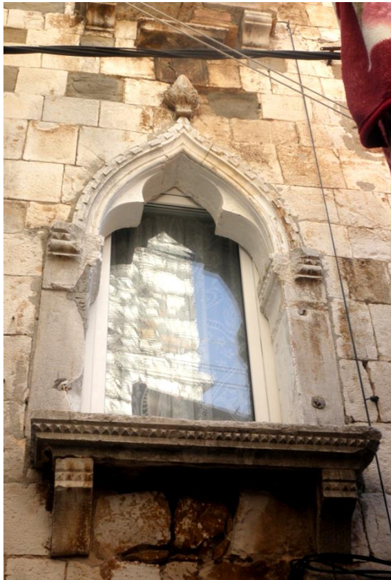
Gotička monofora s klupčicom na konzolama na kući br.19 (lijevo) i renesansna monofora drugog kata na kućnom broju 35 (desno) u današnjoj Riječkoj ulici
