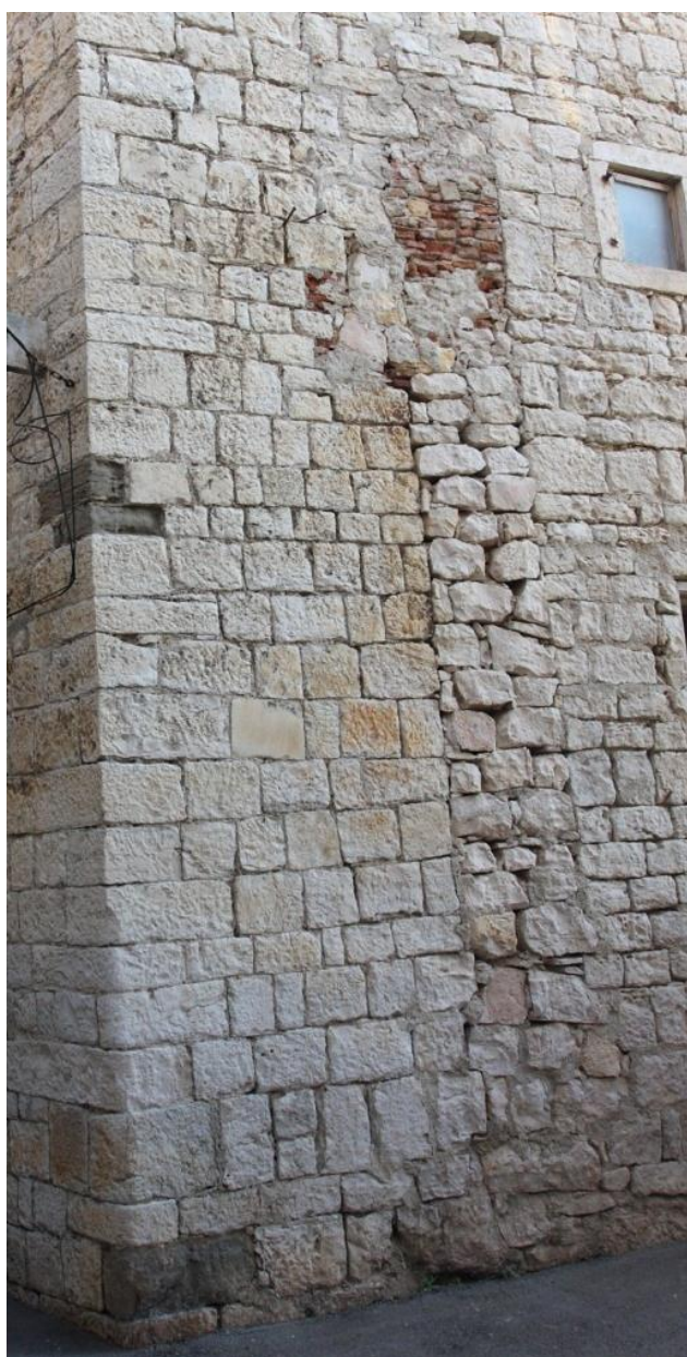
Vertikalne fuge na zapadnom pročelju kuće u današnjoj Riječkoj ulici (lijevo) i na zapadnom pročelju kuće u današnjoj Ulici sv. Mihaela ( desno) fotografije: L. Jonjić, 2011.
