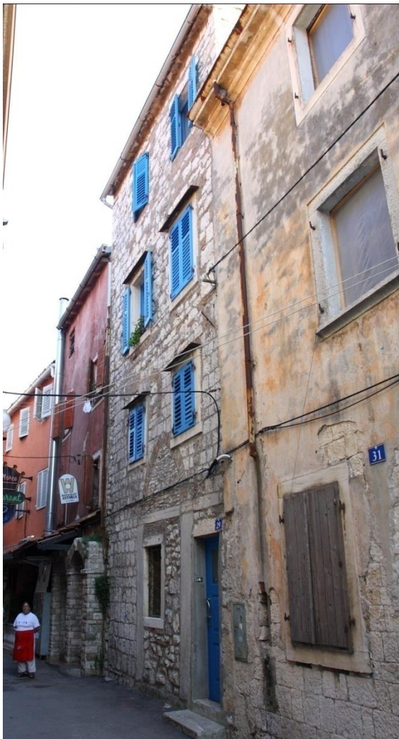
Primjeri fugiranja pročelja u Riječkoj ulici (lijevo) i u Ulici D. Ahierija (dolje)
