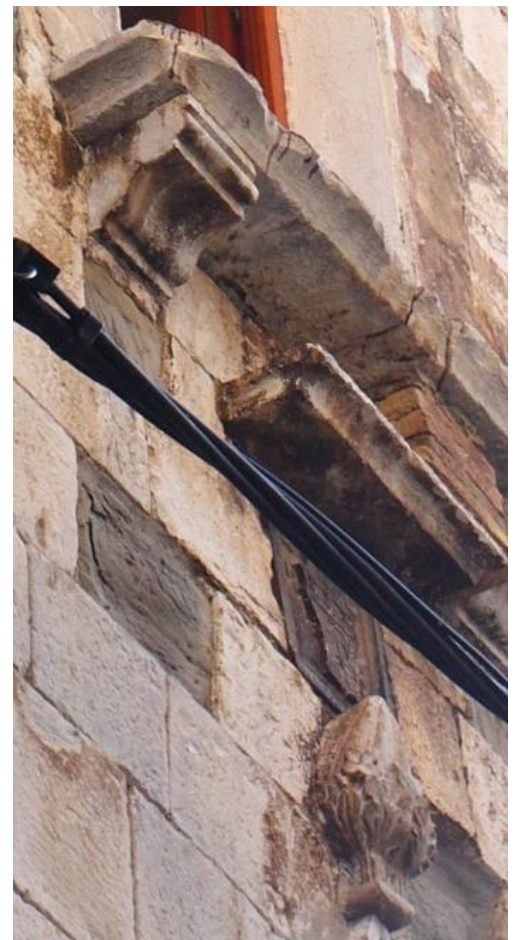
Kuća u današnjoj Riječkoj ulici br. 19: crtež obiteljskog grba Barozzo (gore) i detalj sjevernog pročelja s akroterijem gotičke monofore, profiliranom okapnicom nad obiteljskim grbom i profilirane klupčice na renesansnoj konzoli (desno) crtež preuzet iz: Contributo all'araldica di Umago , str. 253. fotografije: J. Peković, 2011.
