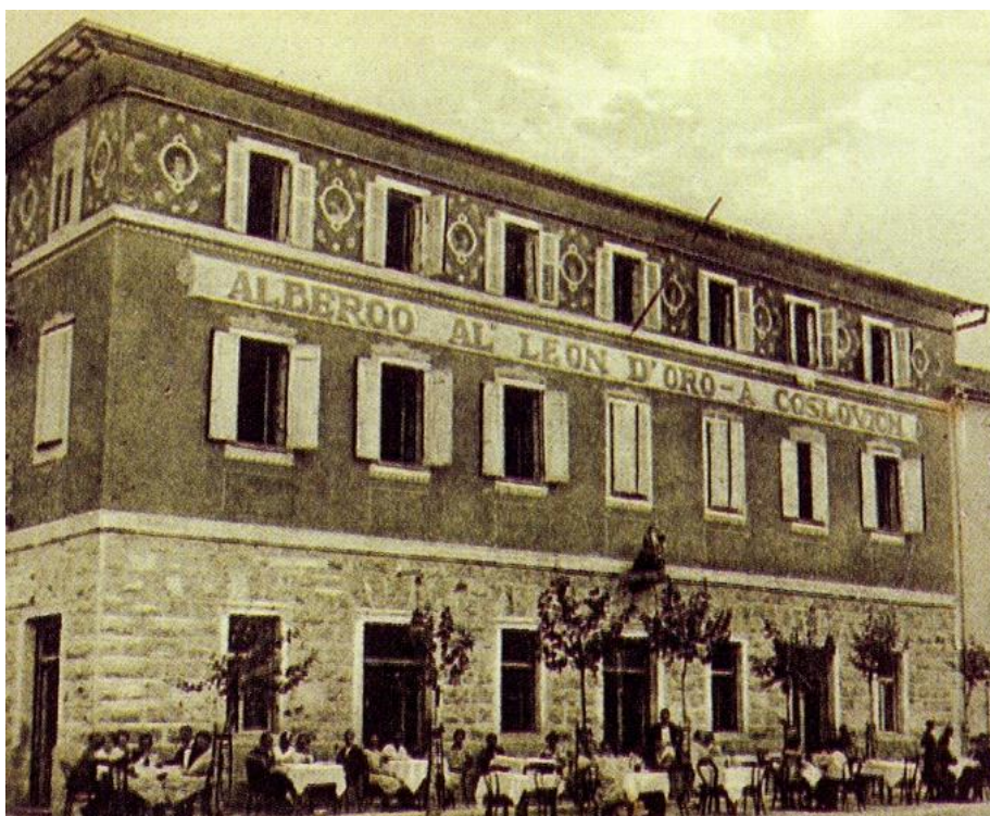
Kazališna dvorana prvog kata hotela Al leon d'oro (gore), zapadno pročelje zgrade nakon dogradnje drugog kata (desno) i zgrade izgrađene koncem 20. stoljeća na istom mjestu (dolje) preuzeto iz: Pozdrav iz Umaga, str. 81. i 83. fotografija: L. Jonjić, 2011.
