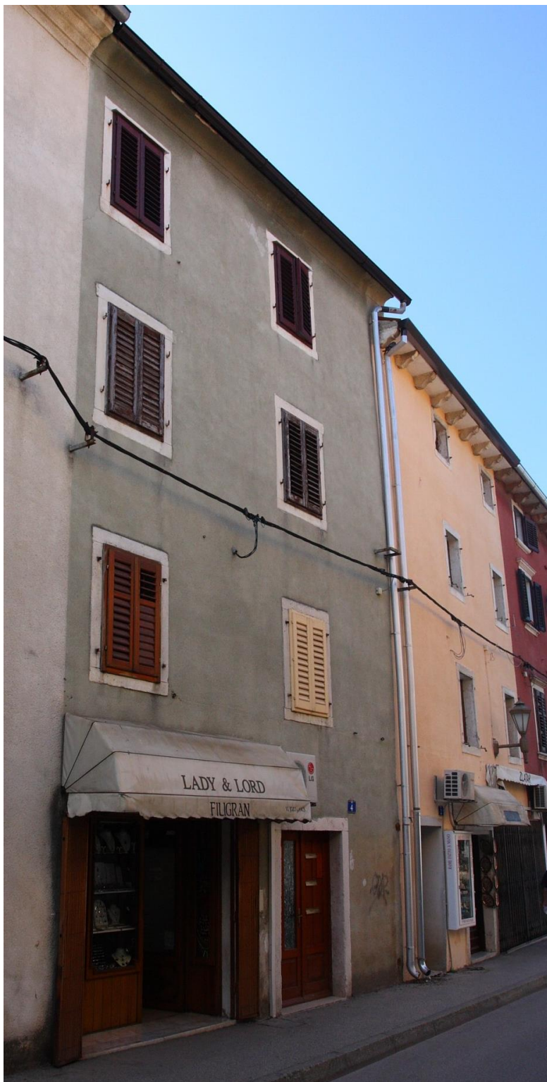
Kuća obitelji Besich (desno, žuto pročelje) i obitelji Nigris (lijevo sivo pročelje) na istočnom potezu današnje Ulice Dantea Alighierija fotografija: L. Jonjić, 2011.
