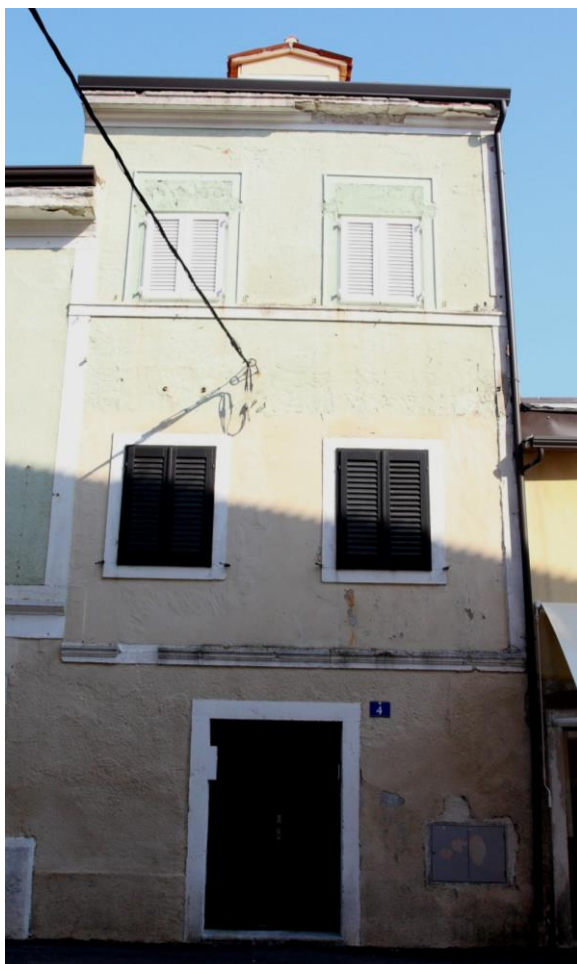
Zapadno pročelje (lijevo) i istočno pročelje (desno)
