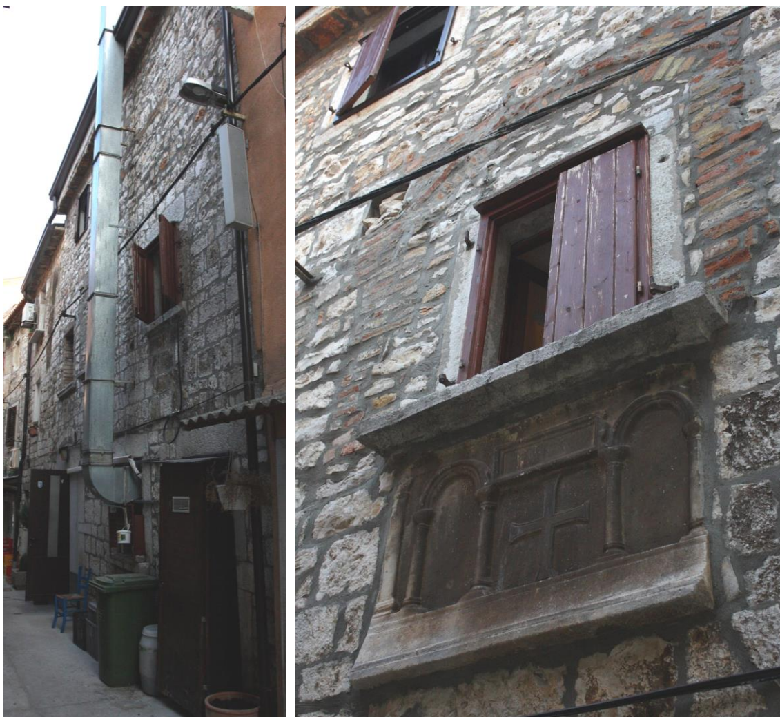
Sjeverno pročelje (lijevo) i detalj pročelja (desno)
