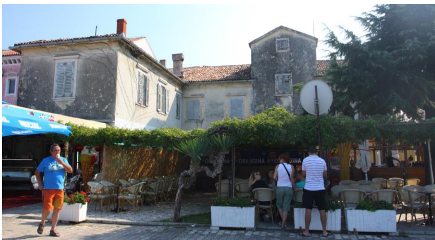
Sjeverno pročelje južnog krila (gore) i pogled sa sjevera (dolje)
