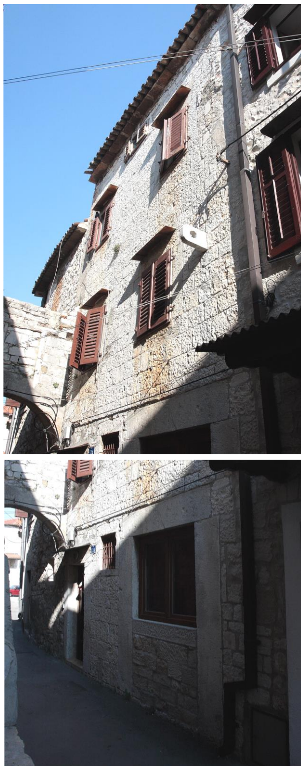
Južno pročelje istočnog dijela kuće
