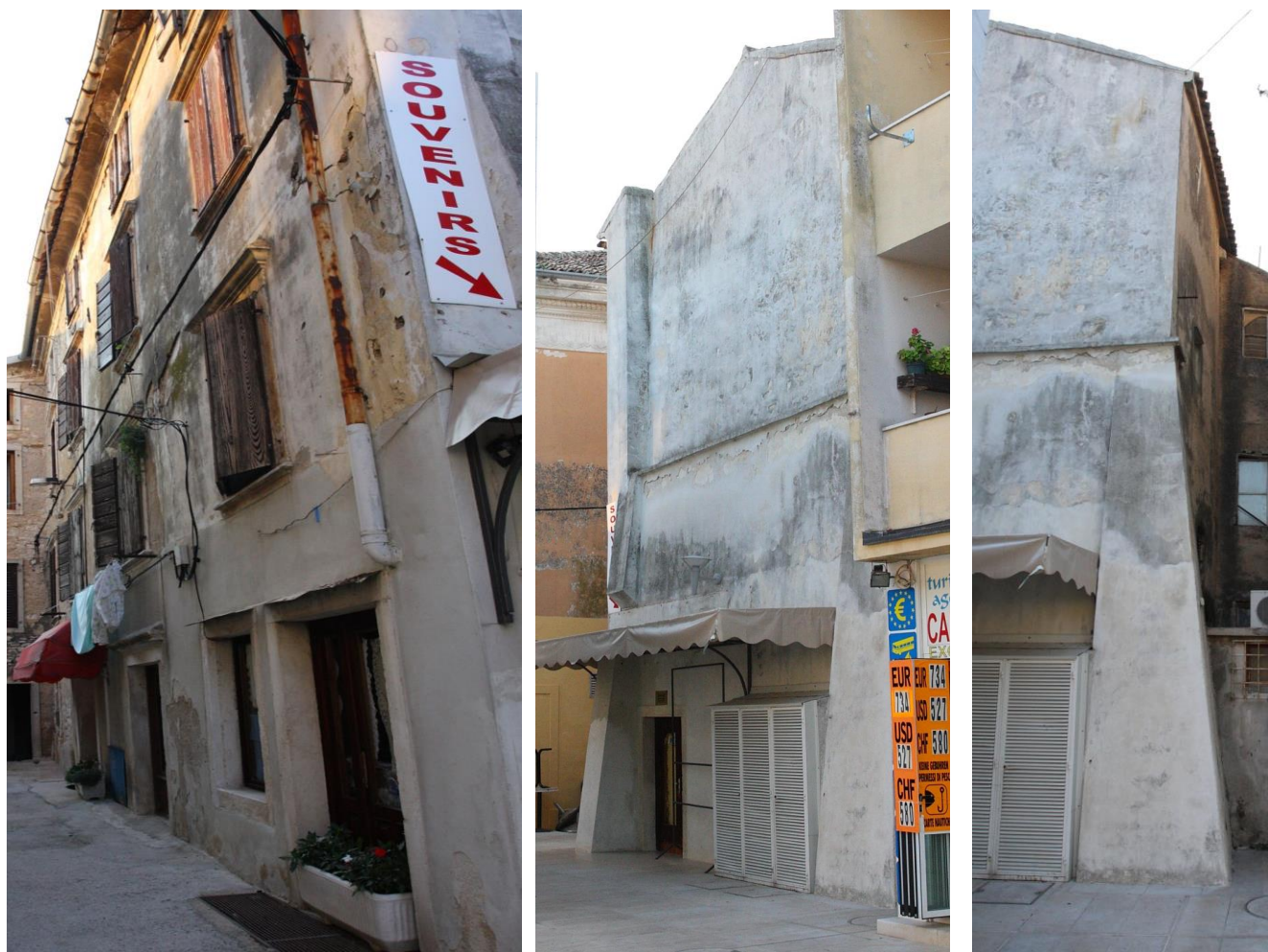
Južno pročelje (lijevo), istočno pročelje (sredina) i sjeveroistočni ugao (desno)
