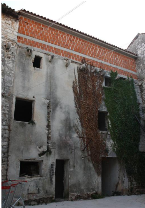
Sjeverno pročelje (lijevo) i južno pročelje (desno gore i dolje)
