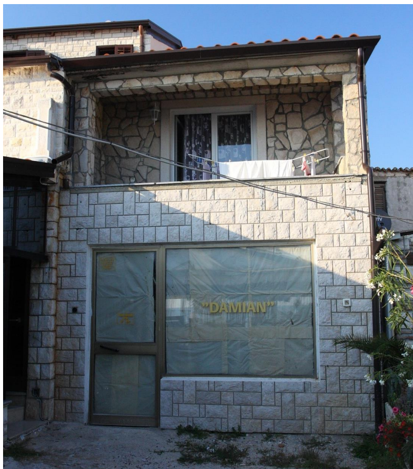
Sjeverno pročelje (lijevo) i južno pročelje (gore)
