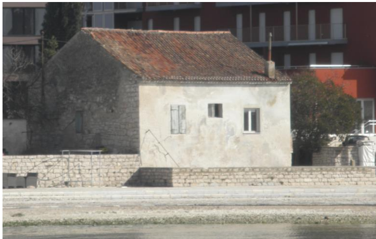
Istočno pročelje (gore), južno pročelje (sredina) i zapadno pročelje (dolje)
