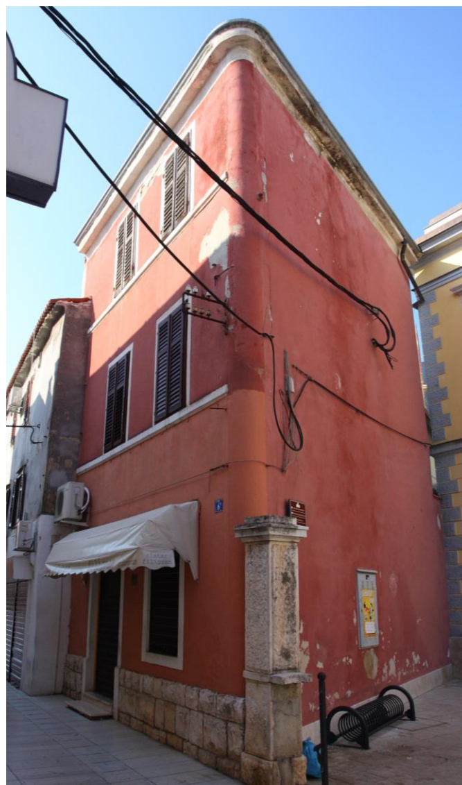
Južno i istočno pročelje
