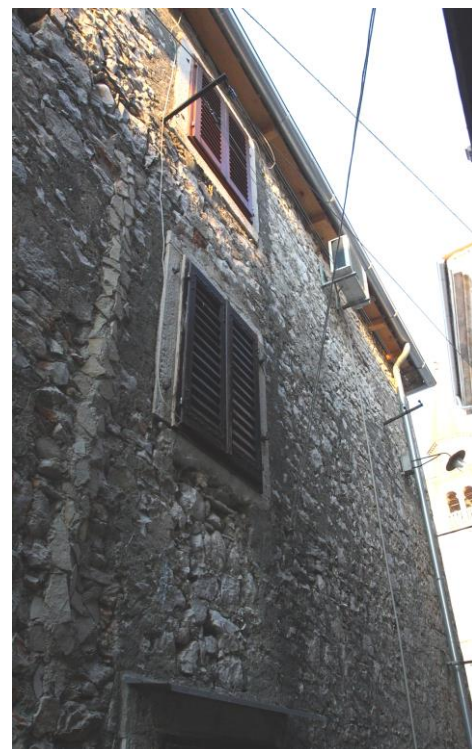
Istočno i sjeverno pročelje (lijevo) i dio južnog pročelja (desno)
