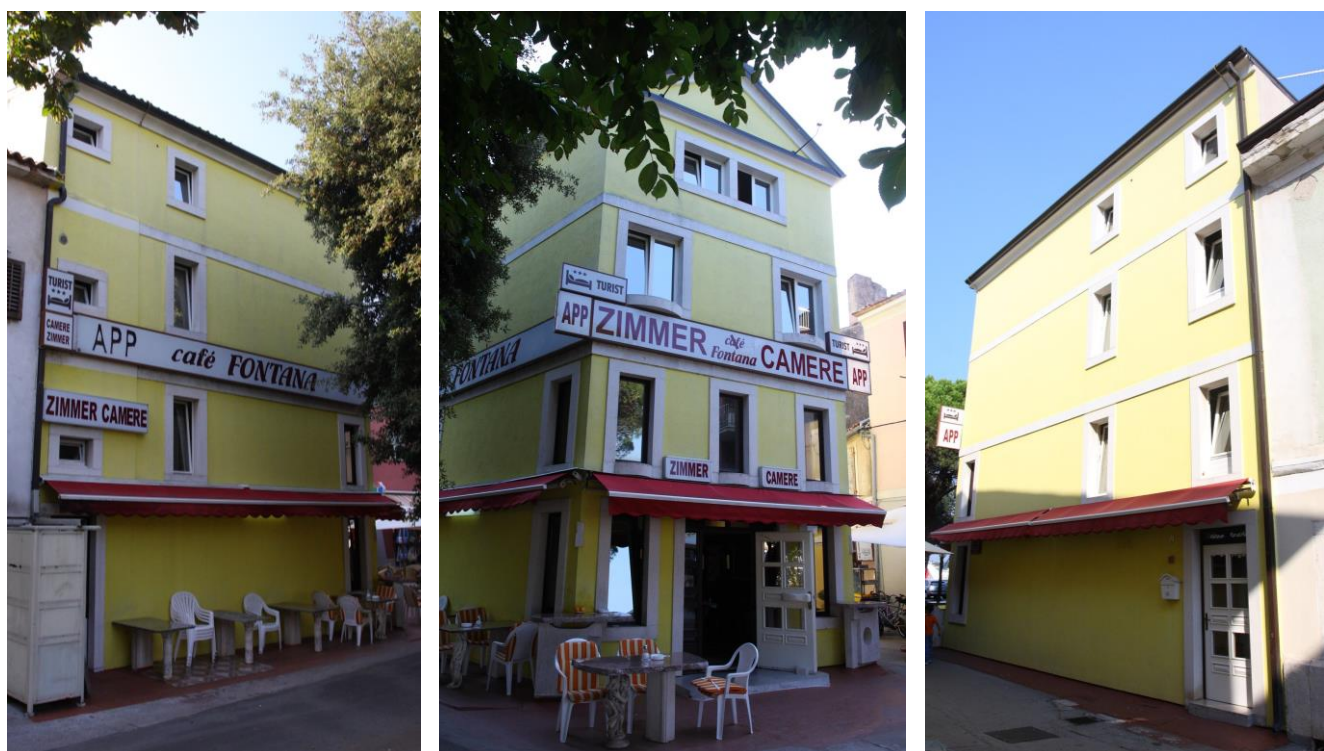
Istočno pročelje (lijevo), sjeverno pročelje (sredina) i zapadno pročelje (desno)
