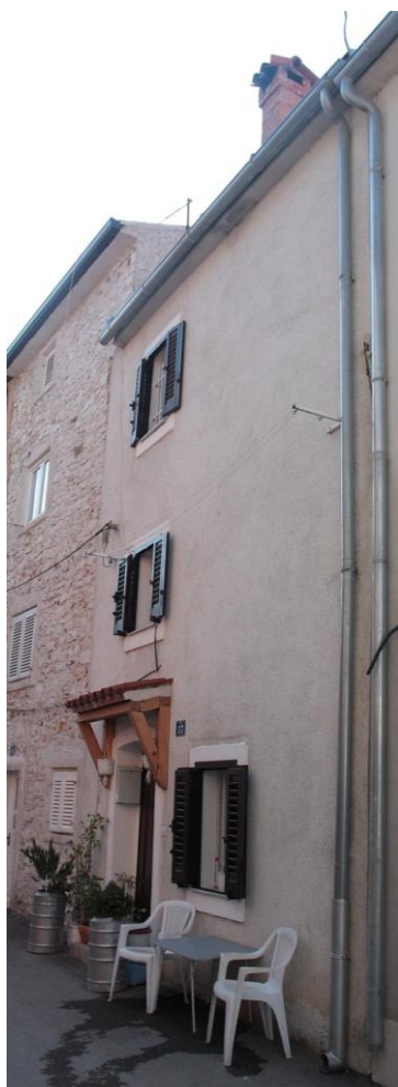
Sjeverno pročelje (lijevo) i južno pročelje (desno)
