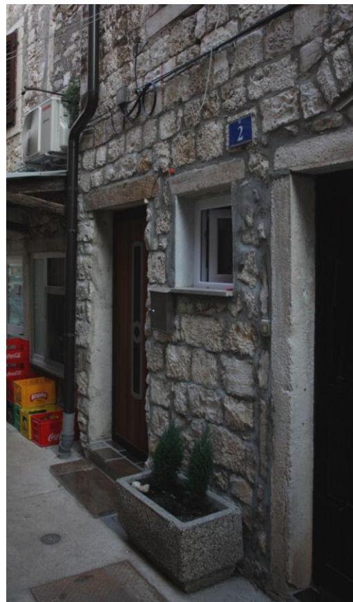
Sjeverno pročelje (gore i desno)
