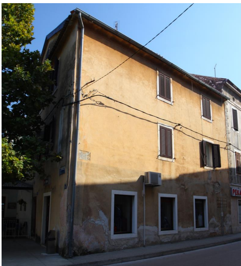
Sjeverozapadni ugao (gore) i zapadno pročelje (dolje)
