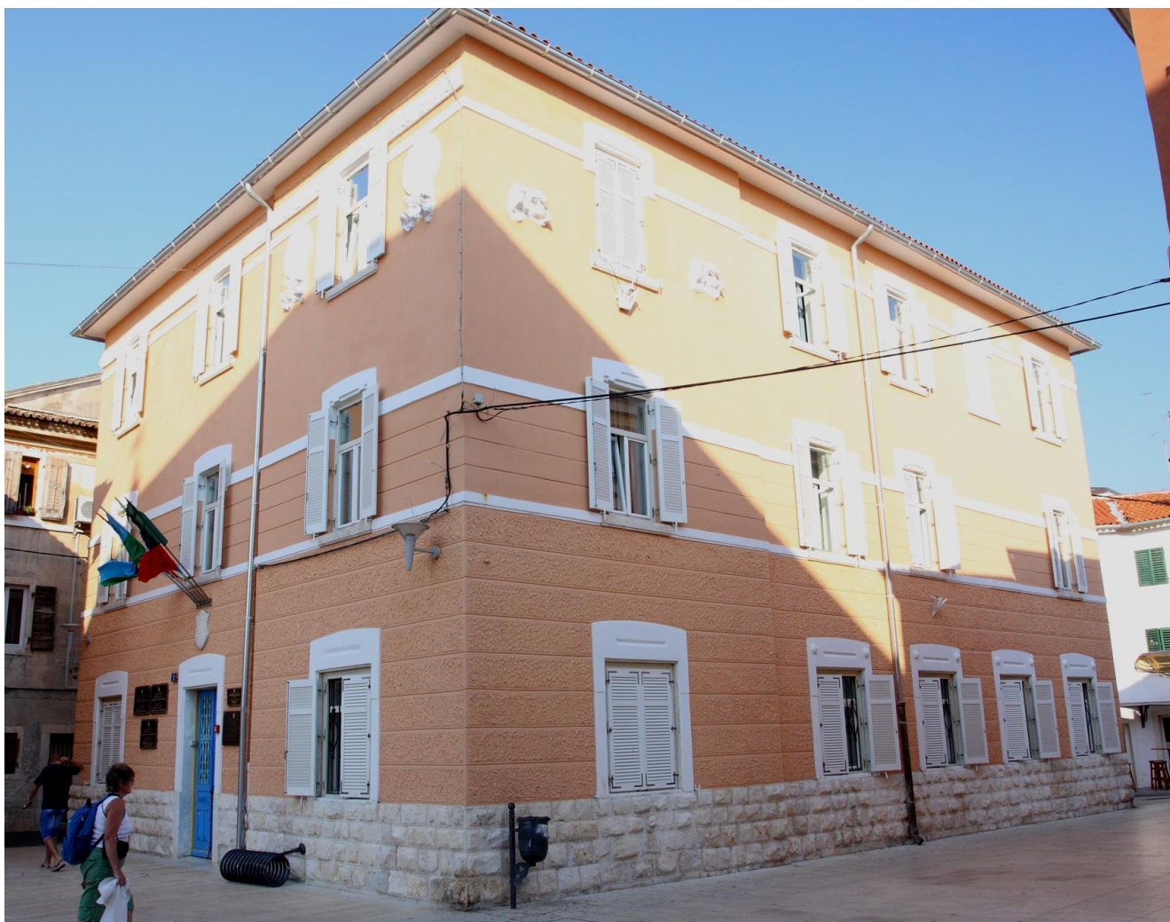
Zapadno i južno pročelje
