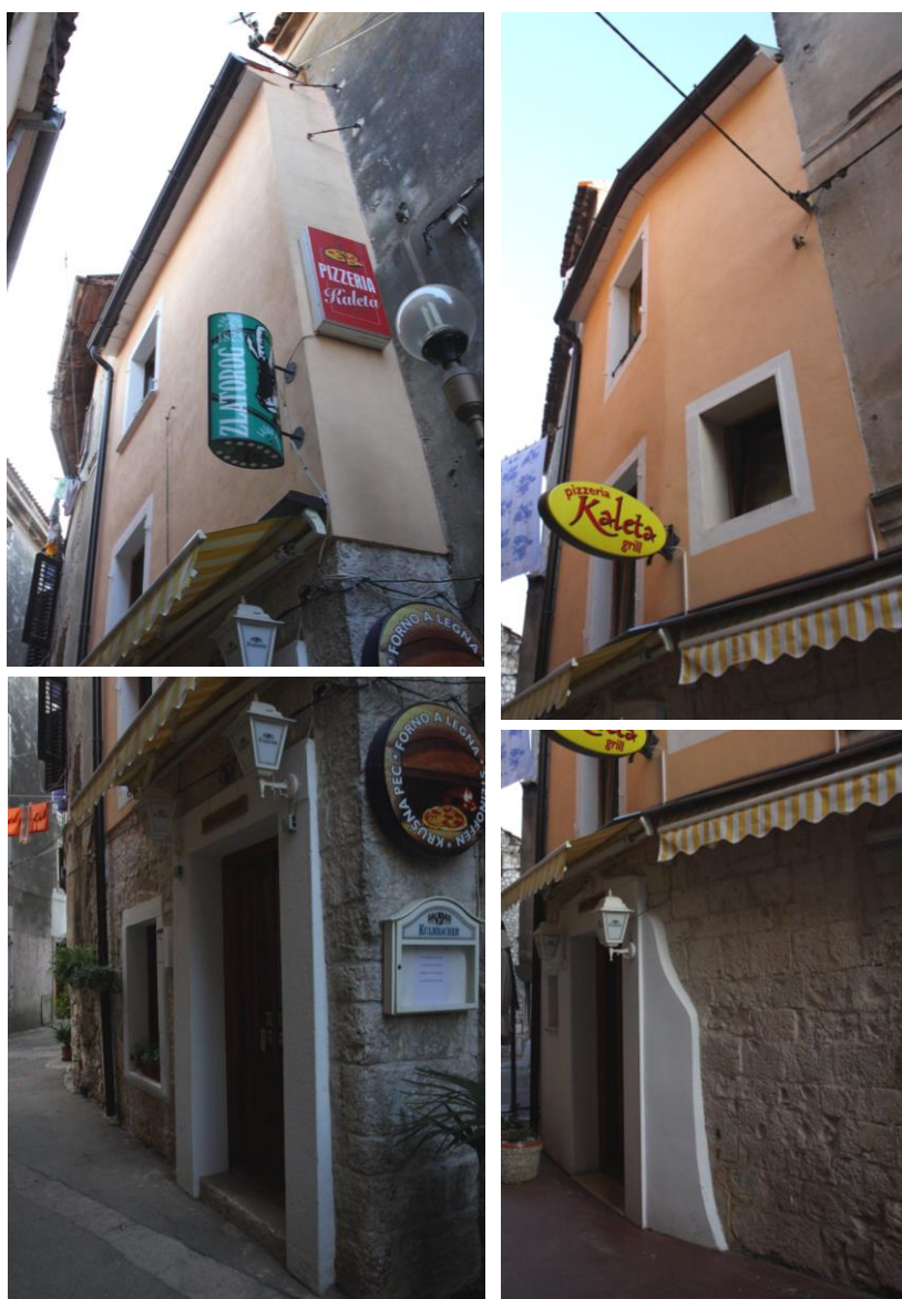
Južno pročelje – prizemlje i katovi (lijevo dolje i gore); sjeverno pročelje – prizemlje i katovi (desno dolje i gore)
