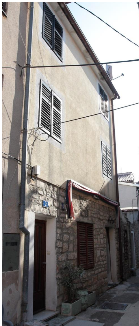
Južno pročelje (lijevo), istočno pročelje (desno gore) i dogradnja potkrovlja (desno dolje)
