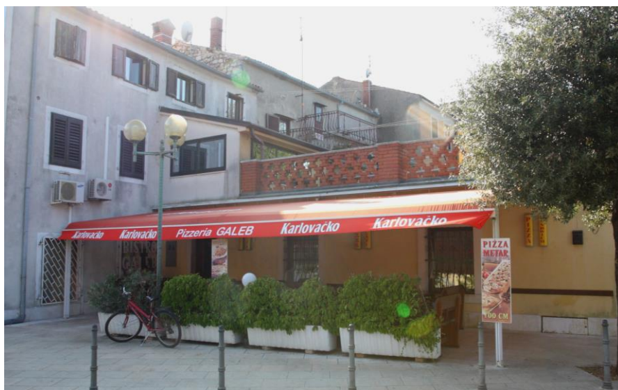
Južno i istočno pročelje (gore) i dogradnje i nadstrešnica uz sjeverno pročelje (dolje)
