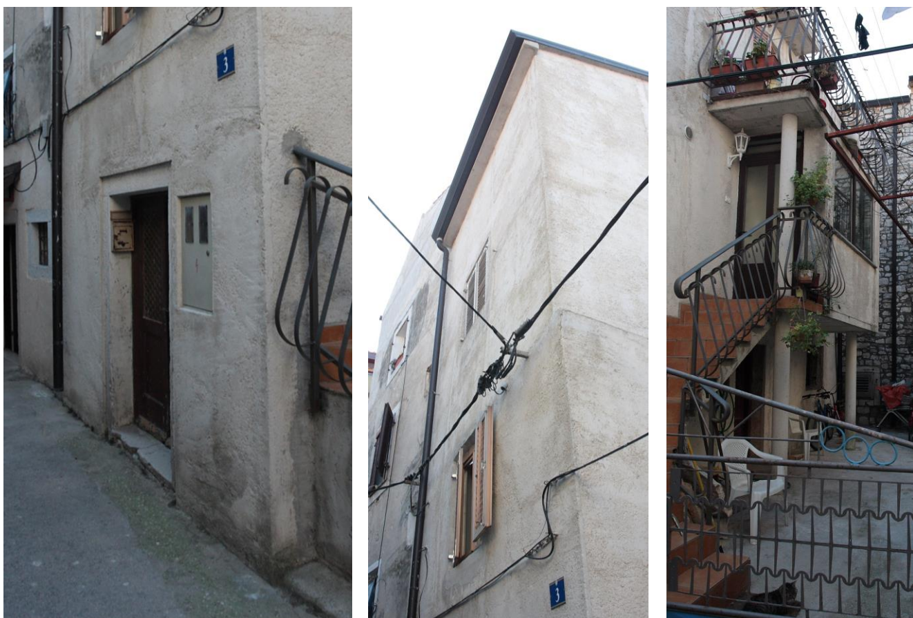
Sjeverno pročelje – prizemlje (lijevo) i katovi (sredina); zapadno pročelje (desno)
