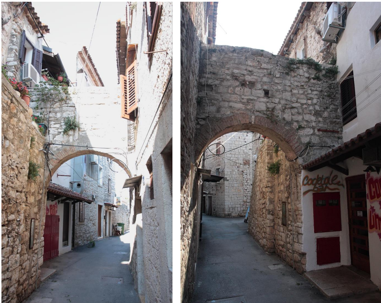
Zid preko Riječke ulice – pogled s istoka (lijevo) i sa zapada (desno)
