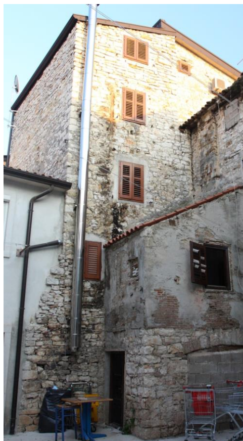
Južno pročelje (desno gore i dolje) i zapadno pročelje (lijevo)
