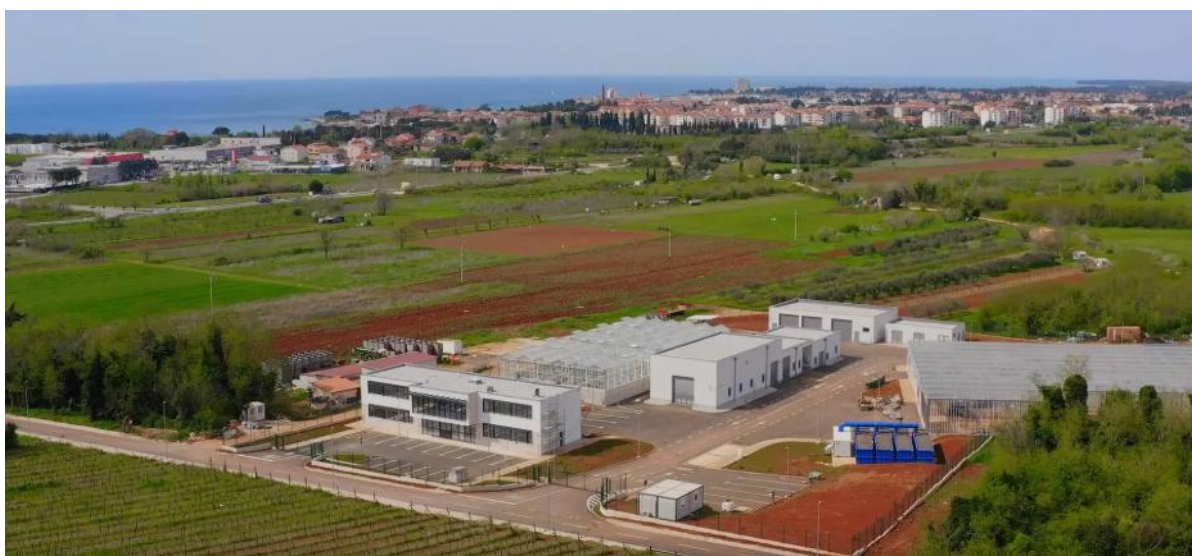
Slika 23– UPOV Umag (izvor fotografije: mrežne stranice Grada Umaga – Umago - https://umag.hr/ )
