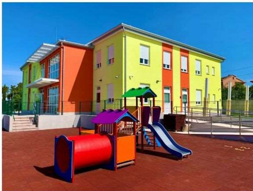
Slika 22 – izgradnja novog dječjeg vrtića u Murinama (izvor fotografije: mrežne stranice Grada Umaga – Umago - https://umag.hr/ )
