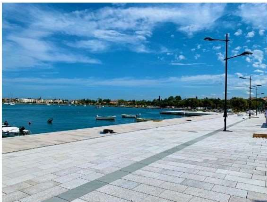
Slika 28 – obnova i uređenje gradske rive od lukobrana do ACI marine (izvor fotografije: mrežne stranice Grada Umaga – Umago - https://umag.hr )
